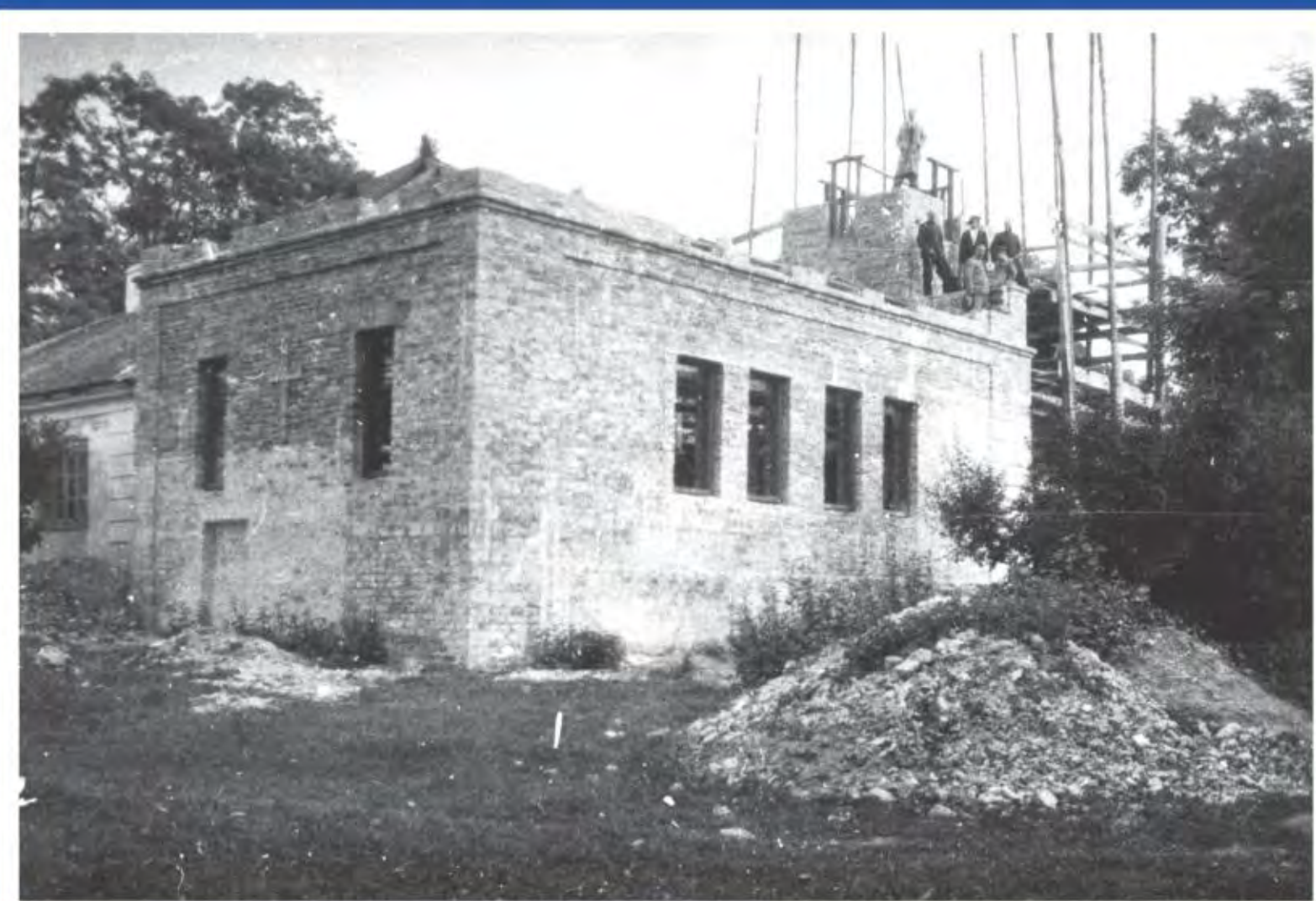
Niesuchojeże – budowa kościoła (fot. 1937 r.)
